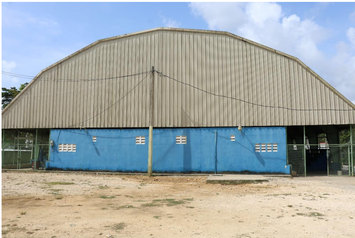
Vista Frontal del Multiuso y/o Polideportivo.
