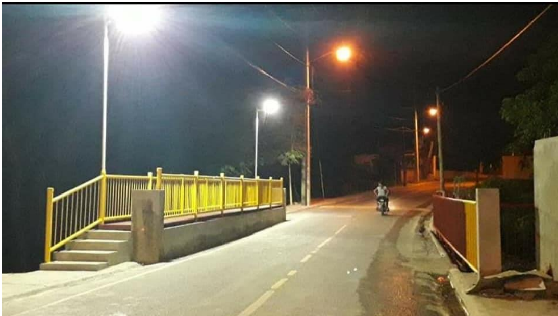
Puente arroyo Grande
