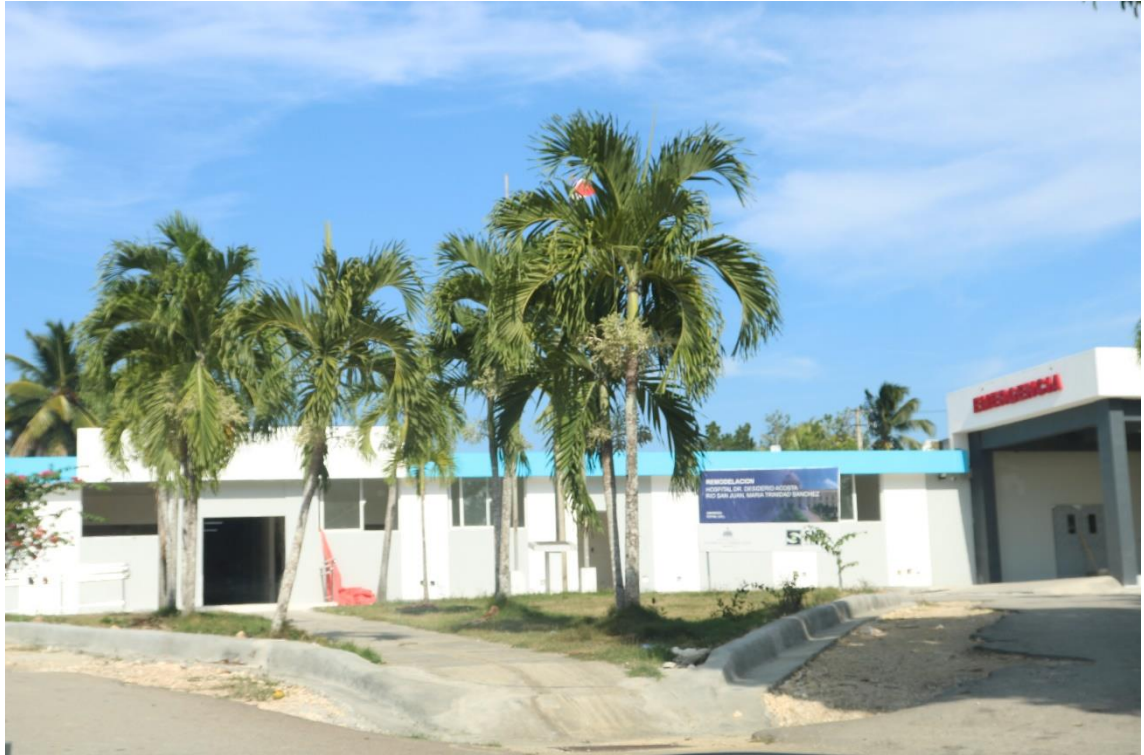
Hospital Desiderio Acosta (actualmente en Reconstrucción)
